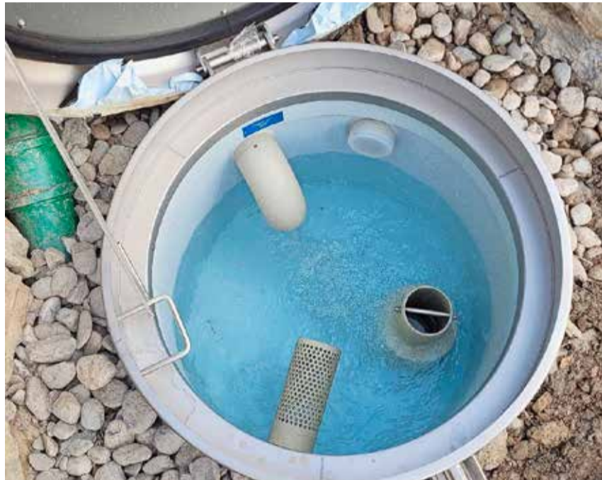
Gefasst: Das Quellwasser sprudelt in den neuen Schacht. Es ist kalt und glasklar, was von seiner guten Qualität zeugt.
