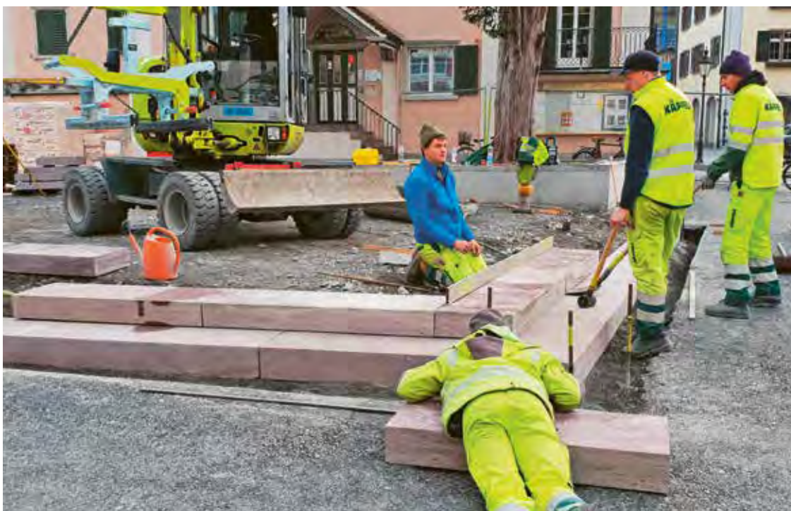
Alles muss exakt stimmen: Das exakte Verlegen der Platten ist Präzisionsarbeit.
